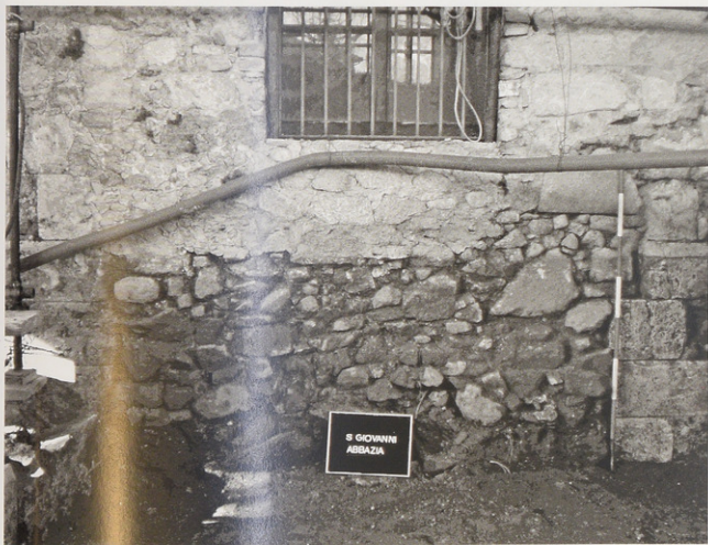
Fig. 4. Abbazia fiorentine, Saggio 4. Muro di chiusura del portale che si apriva all'estremità meridionale dell'ala Est del monastero (visto da S.).
