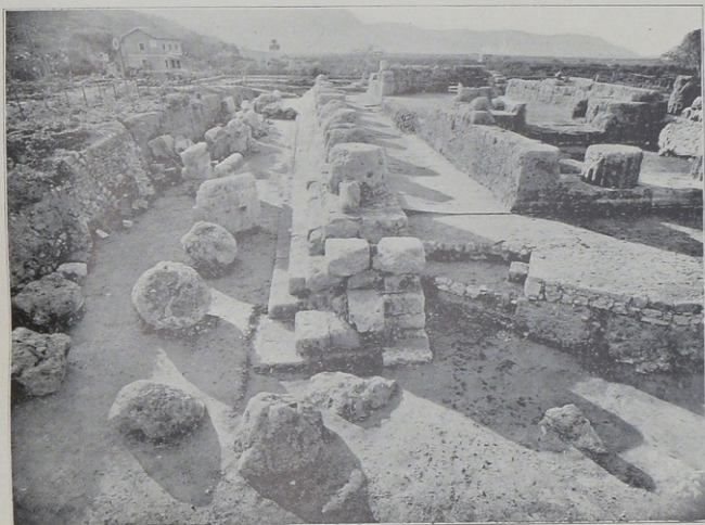
FIG. 17. — Il Tempio dopo lo scavo, visto dall'angolo SE.
