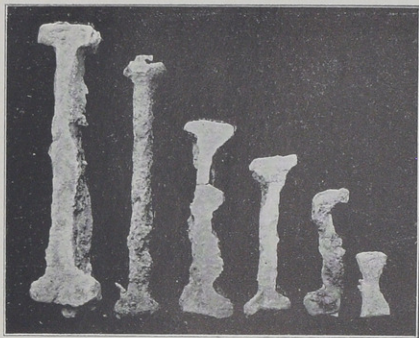
FIG. 39. — Esempi di chiavi a doppio T di diversa grandezza, a Z ed a doppia coda di rondine.
