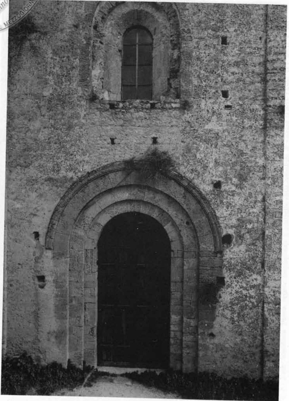
Fig. 4 - Gerace, Cattedrale, Facciata. La finestra riportata allo stato originario dal Martelli 1949-50 [AS BB AA AS]
