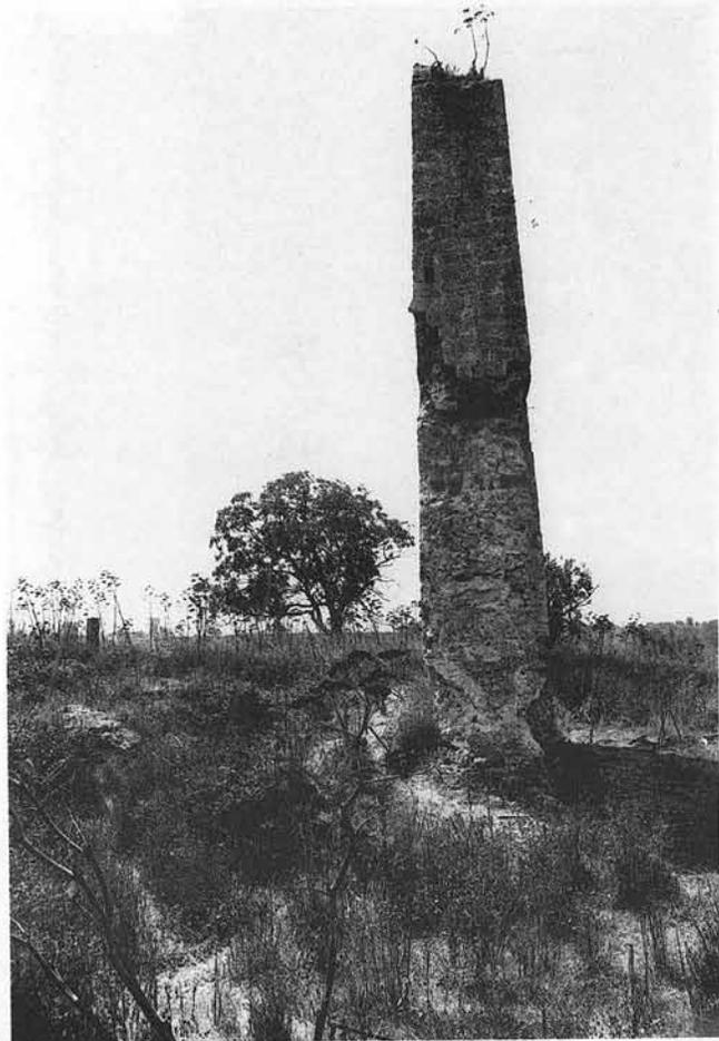
Fig. 13. Mileto Vecchia. La *Scarpa* vista da nord. In questa veduta di profilo è possibile notare la diminuzione dello spessore verso l'alto e lo spiovente del coronamento.
